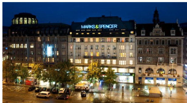
Multifunkční budova Melantrich, Praha
