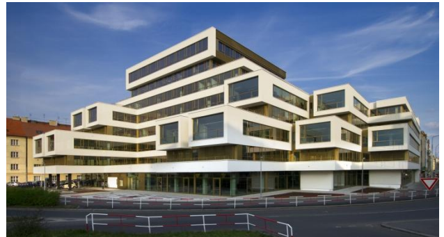
Multifunkční budova Qubix, Praha
